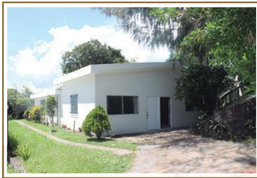
Remodelación de Biblioteca del CNJ
